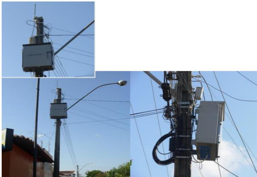
Figura 2: Injeção do sinal de internet na rede elétrica da CEMAR. Na foto da esquerda o sinal é recebido através de antena. Na foto menor há o detalhe da recepção do sinal pela antena. A foto da direita ilustra o repetidor localizado a aproximadamente 500 metros do equipamento master. Fotos do autor, 2009.
