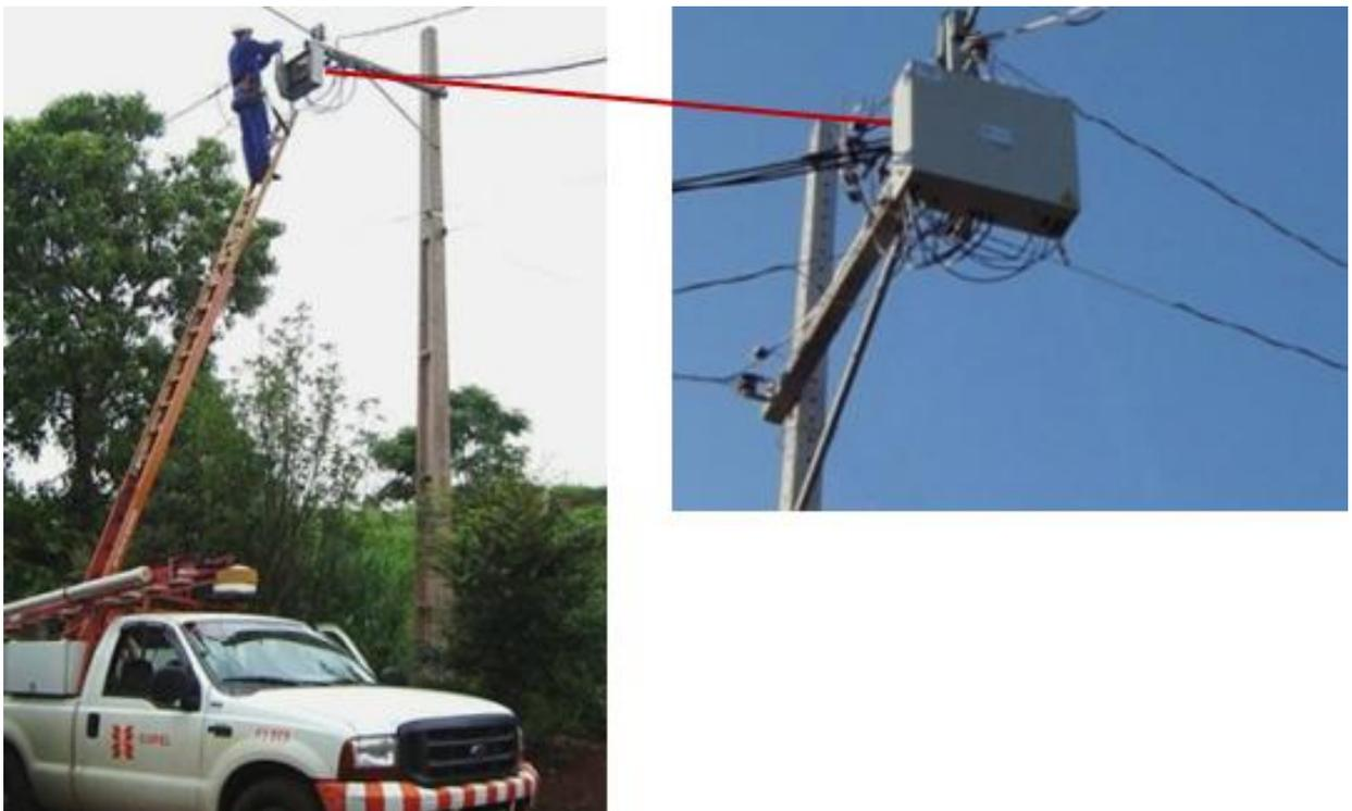
Figura 20: Aparelho que centraliza as medições inteligentes é instalado na área de concessão da Copel. (75) A fotografia da direita mostra o detalhe da caixa e a colocação em local de difícil acesso para o consumidor de forma a evitar a possibilidade de fraude.
