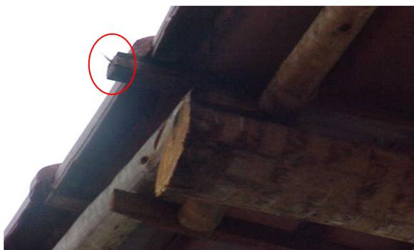
**Figura 4.1** Gradeamento de telhado exposto, com comprometimento de sua durabilidade.
