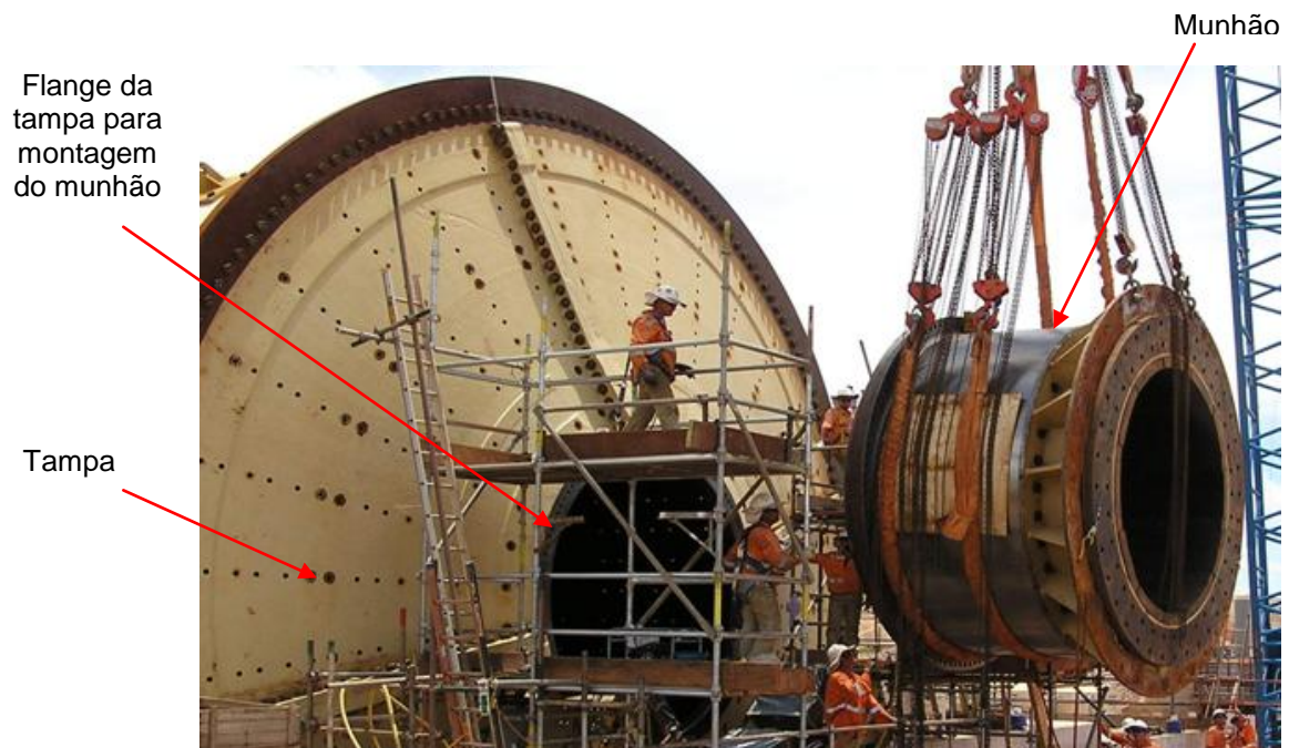
Figura 3 – Montagem de um munhão em uma tampa de moinho
