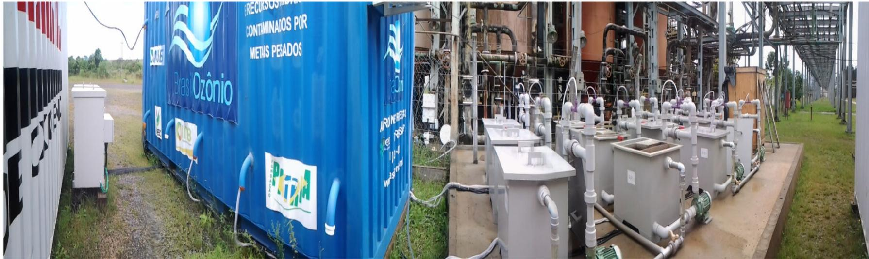
FIGURA 20 - Vista panorâmica do sistema instalado para tratamento da bacia 027E - containers e reatores
