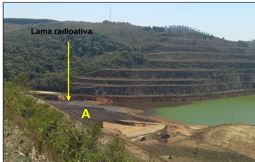
FIGURA 9 – Corpo A da cava da mina onde são depositados rejeitos do processo de tratamento da DAM.
