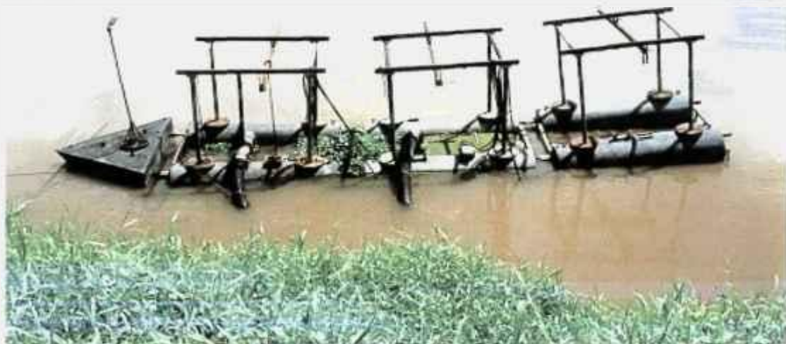
FIGURA 20 – Captação de água no rio do Ribeira de Iguape (SABESP).
