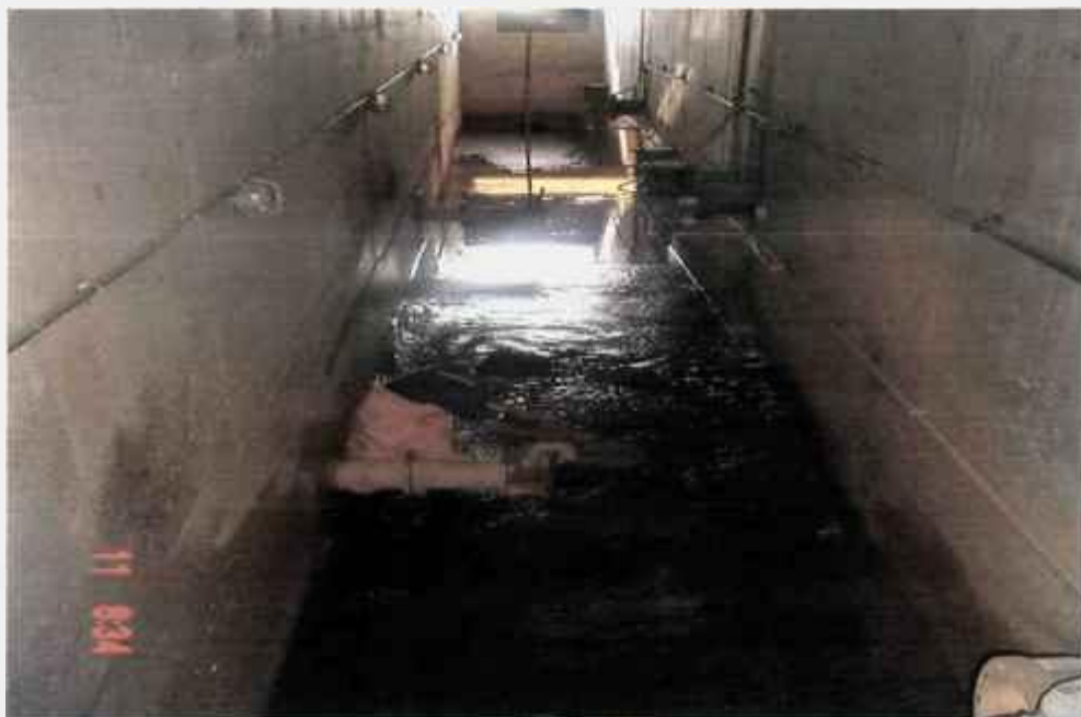
FIGURA 27 – Liberação do lodo retido no decantador.
