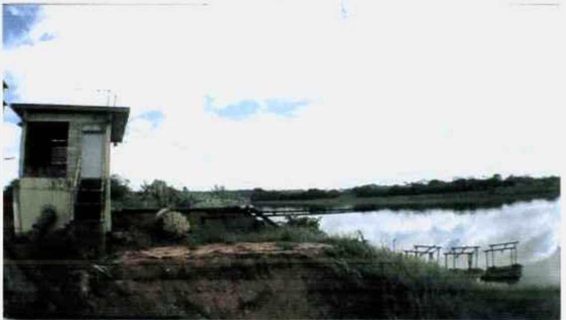
FIGURA 19 – Estação de captação de água no rio do Ribeira de Iguape (SABESP).
