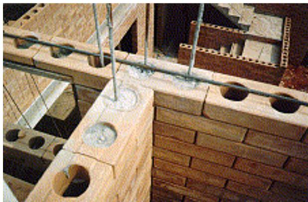
Figura 8. Amarração em encontro de paredes e detalhe do tijolo furado
