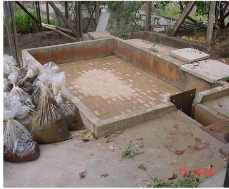
Figura 5. Leito de secagem piloto da Unicamp. Fonte: Porras et al. (2005).
