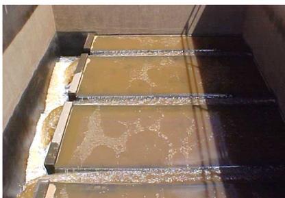
Figura 4. Lodo de ETA no decantador. Fonte: Cordeiro (2001).
