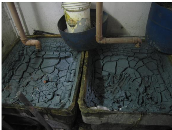
FIGURA 20 – Leito de secagem em condições precárias
