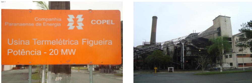
FIGURA 9 - Usina Termelétrica de Figueira
