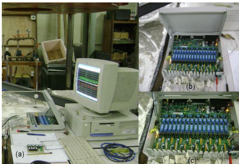
Fotografia 23. (a) visão geral do sistema de aquisição de dados, (b) aspecto do equipamento de aquisição e (c) detalhe dos canais onde são ligados os sensores e das mico-chaves.
