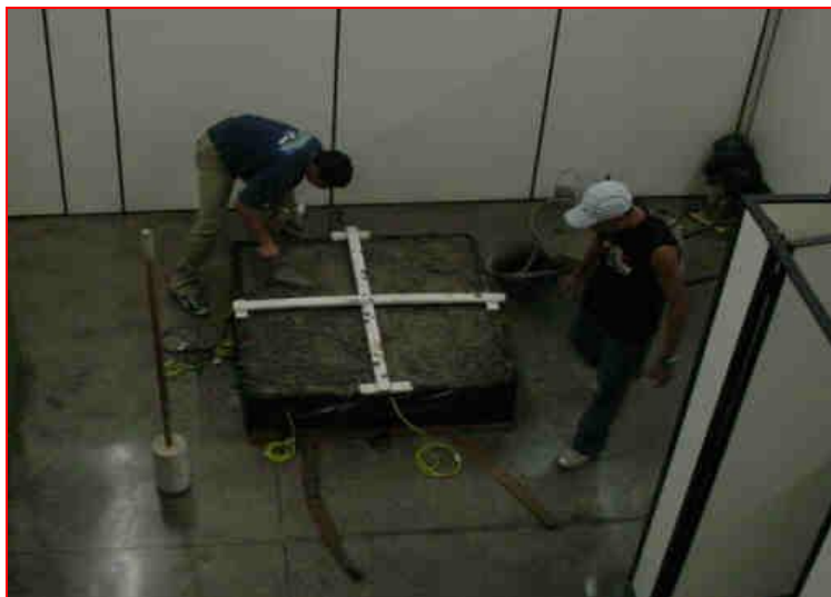
Fotografia 44. Aspecto da placa em sua fase final de construção.
