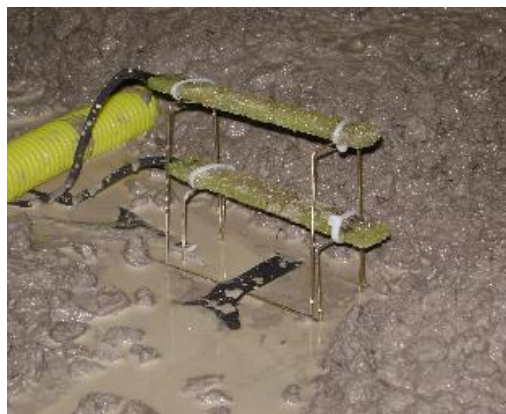
Fotografia 20. Proteção dos sensores com concreto antes da colocação da totalidade de massa. Isso evita que ocorra algum deslocamento dos sensores, devido à pressão que a massa impõe sobre esses componentes.
