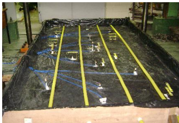
Fotografia 18. Colocação da manta plástica para evitar a aderência da placa de concreto. Vista do posicionamento dos sensores na placa e colocação dos conduítes para resfriamento ou aquecimento do fundo da placa.
