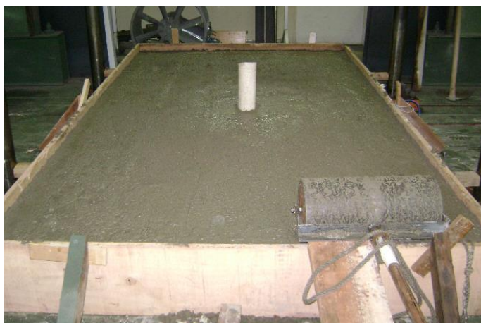
Fotografia 16. Colocação da base sobre o subleito. No centro foi colocado um tubo de 120,0mm de diâmetro para moldar o poço onde foi colocada a célula de carga.
