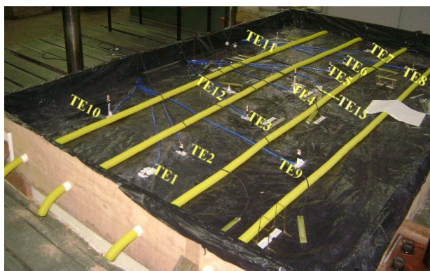
Fotografia 24. Posição dos termômetros dentro do molde do pavimento, fixados sobre a base, antes da concretagem da placa.
