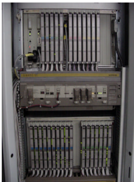
FIGURA 33 – Controlador Lógico Programável do cíclotron Cyclone 30
