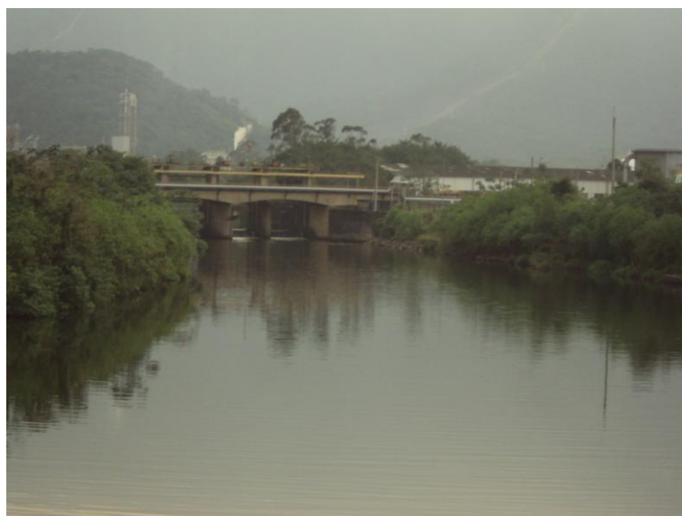
FIGURA 16 – Rio Cubatão (P6) – Refs. Ponte Rod. Côn. D. Rongoni e Barragem da Refinaria RPBC e da Fosfértil
