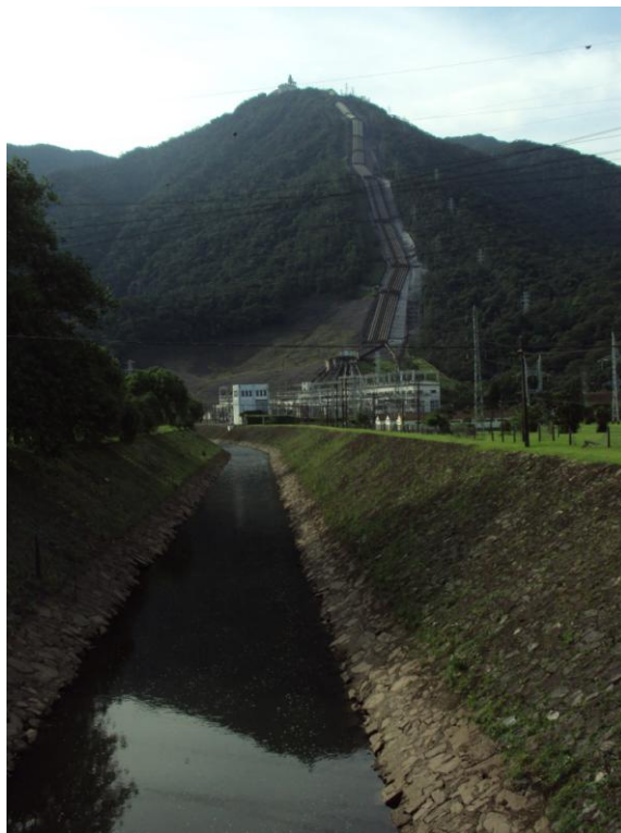
FIGURA 12 – Canal de Fuga I – Usina Henry Borden (P3).
