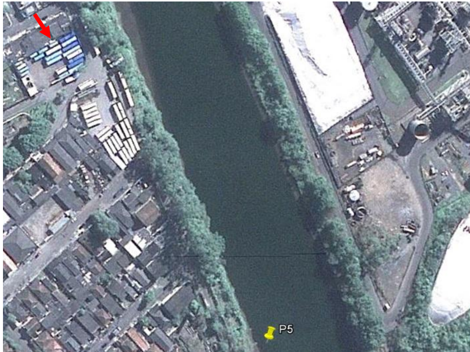
FIGURA 53 – Pátio de ônibus as margens do rio Cubatão (23°52'33.00"S 46°24'47.86"O), localizado próximo ao P5.
