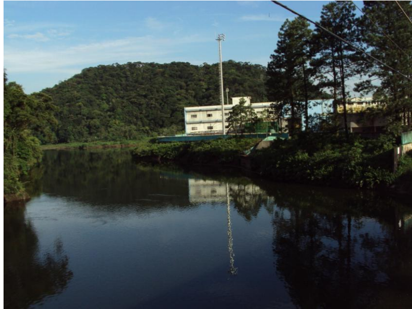
FIGURA 11 - Rio Cubatão (P2) e ETA-3 - Estação de Tratamento de Água
