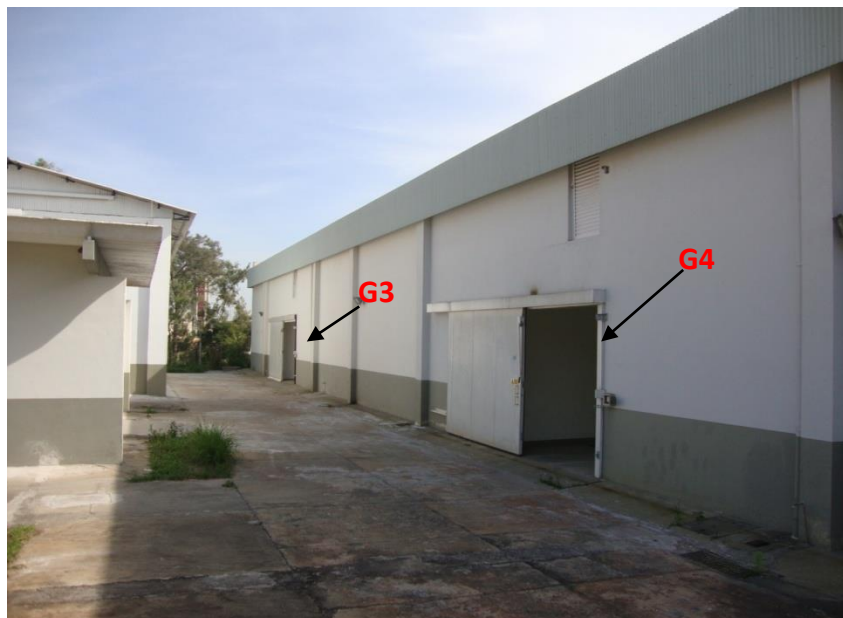
Figura 8. Entradas dos galpões de armazenamento de rejeitos radioativos
