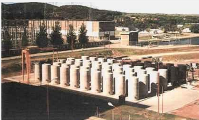
Figura 2.6 - Silos verticais de concreto armado para armazenagem de combustível nuclear queimado
