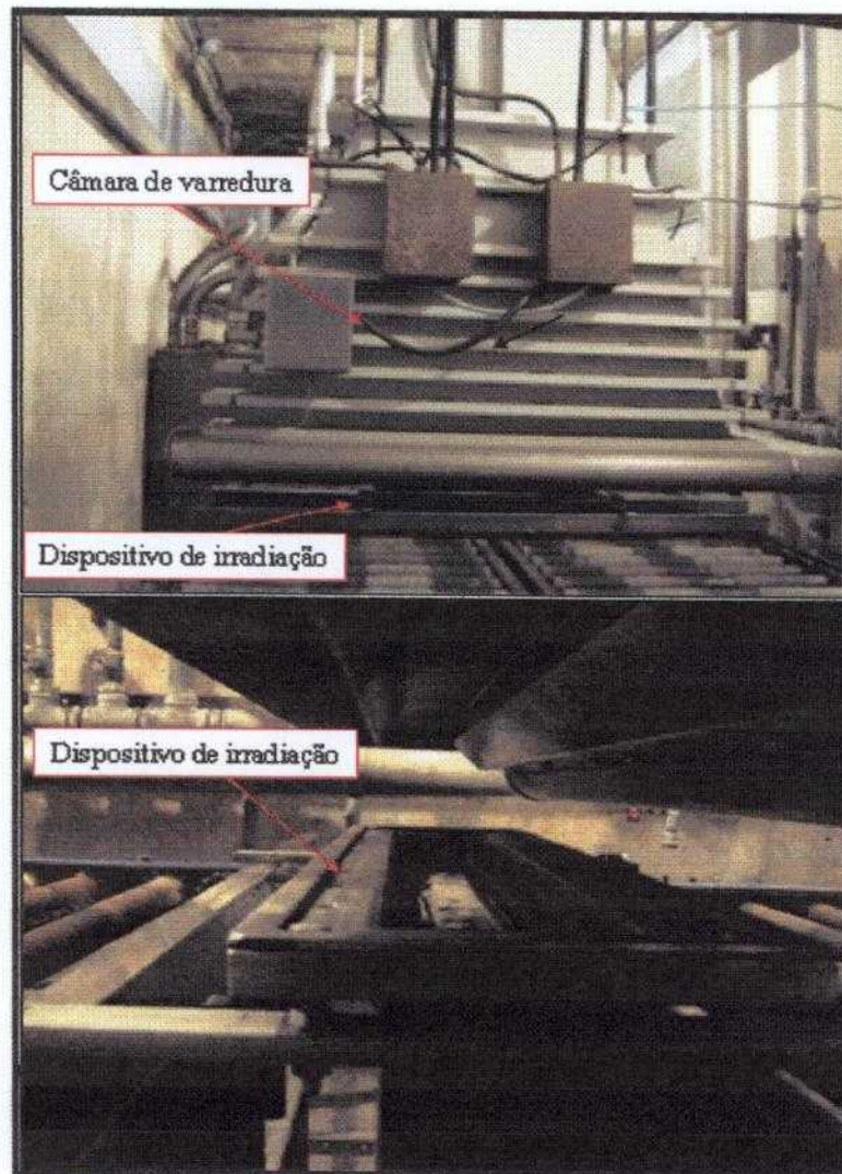
FIGURA 9 – Parte do conjunto do sistema de tratamento e efluente em tratamento
