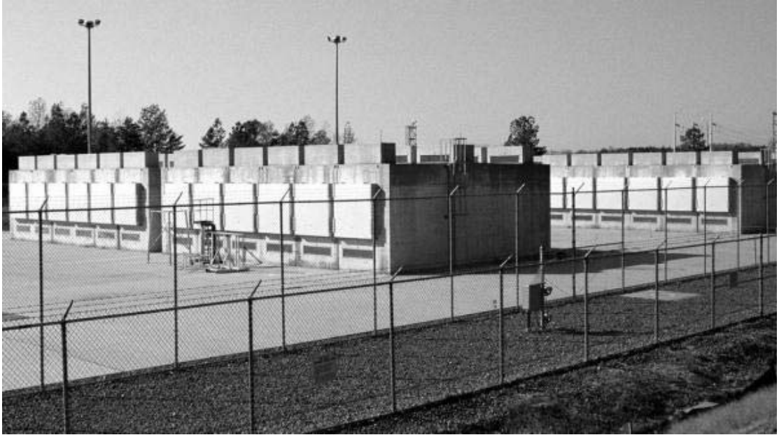
Figura 47 – Instalação de Calvert Cliffs - EUA de armazenagem seca temporária de cascos na posição horizontal.
