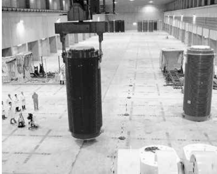
Figura 40 - Interior da instalação de Gorleben, na qual podem ser vistos os cascos de armazenagem de CNQ.
