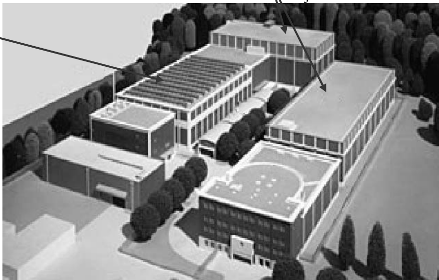
Figura 48 - Instalação de ZWILAG, Suíça, para armazenagem seca de CNQ. Fonte: Zwilag (2004)
