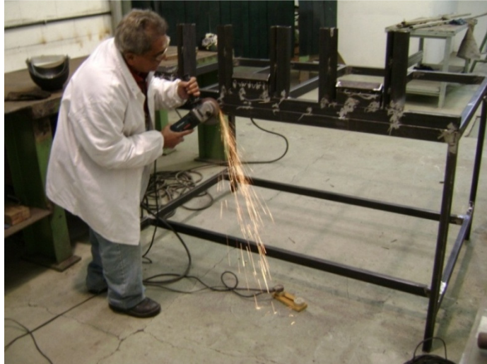
FIGURA 29 - Fabricação de estrutura metálica para caixa protótipo.
