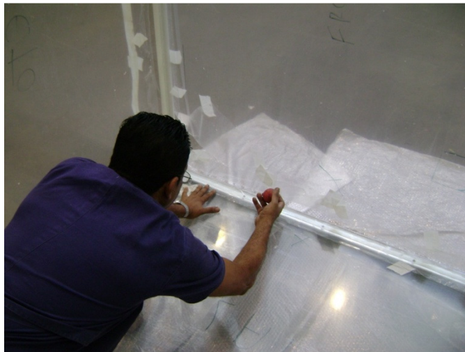
FIGURA 25 – Etapa de montagem – Colagem.
