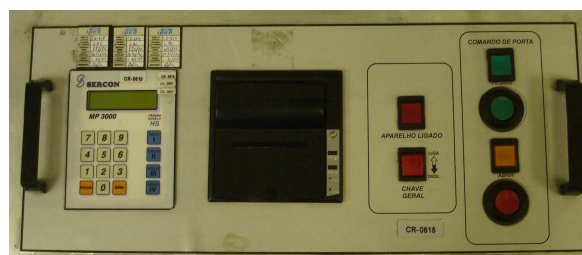
FIGURA 33 - Painel de Controle da autoclave, controla a pressão, temperatura e tempo de esterilização.
