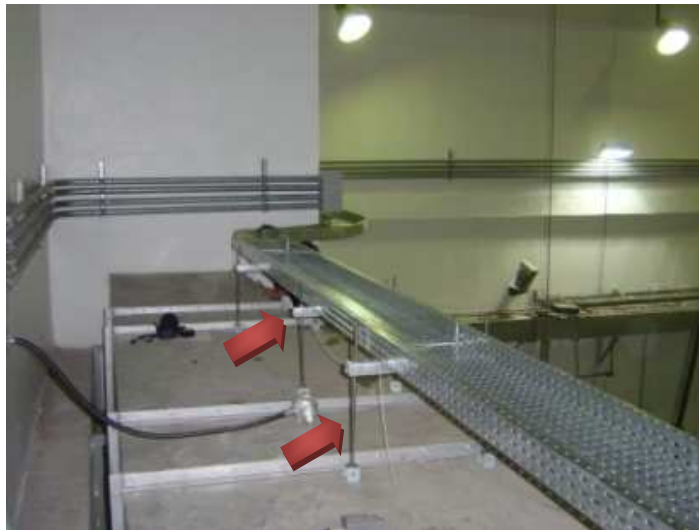
FIGURA 4.4 (c) – Vista dos Suportes para Tubulação do Novo PTS Fixado nos Dutos de Ventilação
