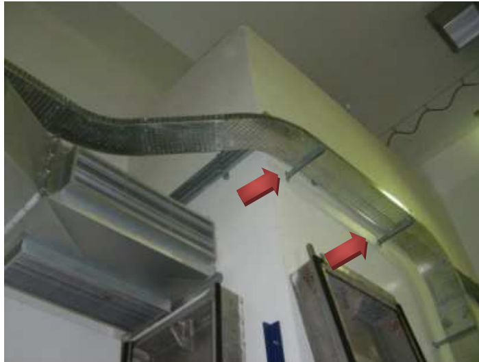
FIGURA 4.4 (b) – Vista dos Suportes para Tubulação do Novo PTS Fixado nas Paredes
