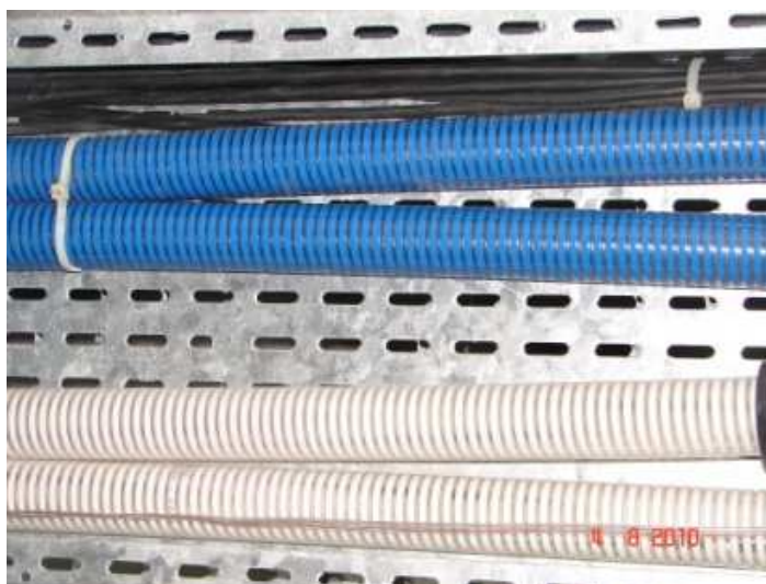
FIGURA 4.4 (a) – Tubulação Branca e Azul Apoiadas Internamente às Calhas de Suportes
