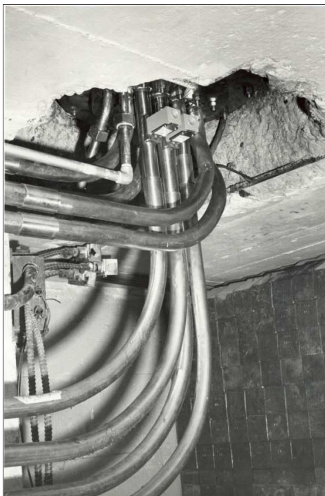
FIGURA 4.6 (b) – Tubulação Metálica no Interior da Piscina do Reator
