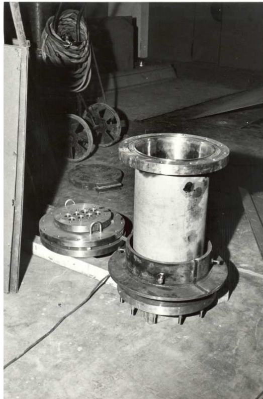
FIGURA 4.6 (a) – Tubulação do Sistema de Irradiação do Antigo PTS Dispositivo de Passagem do Porão para o Fundo da Piscinar
