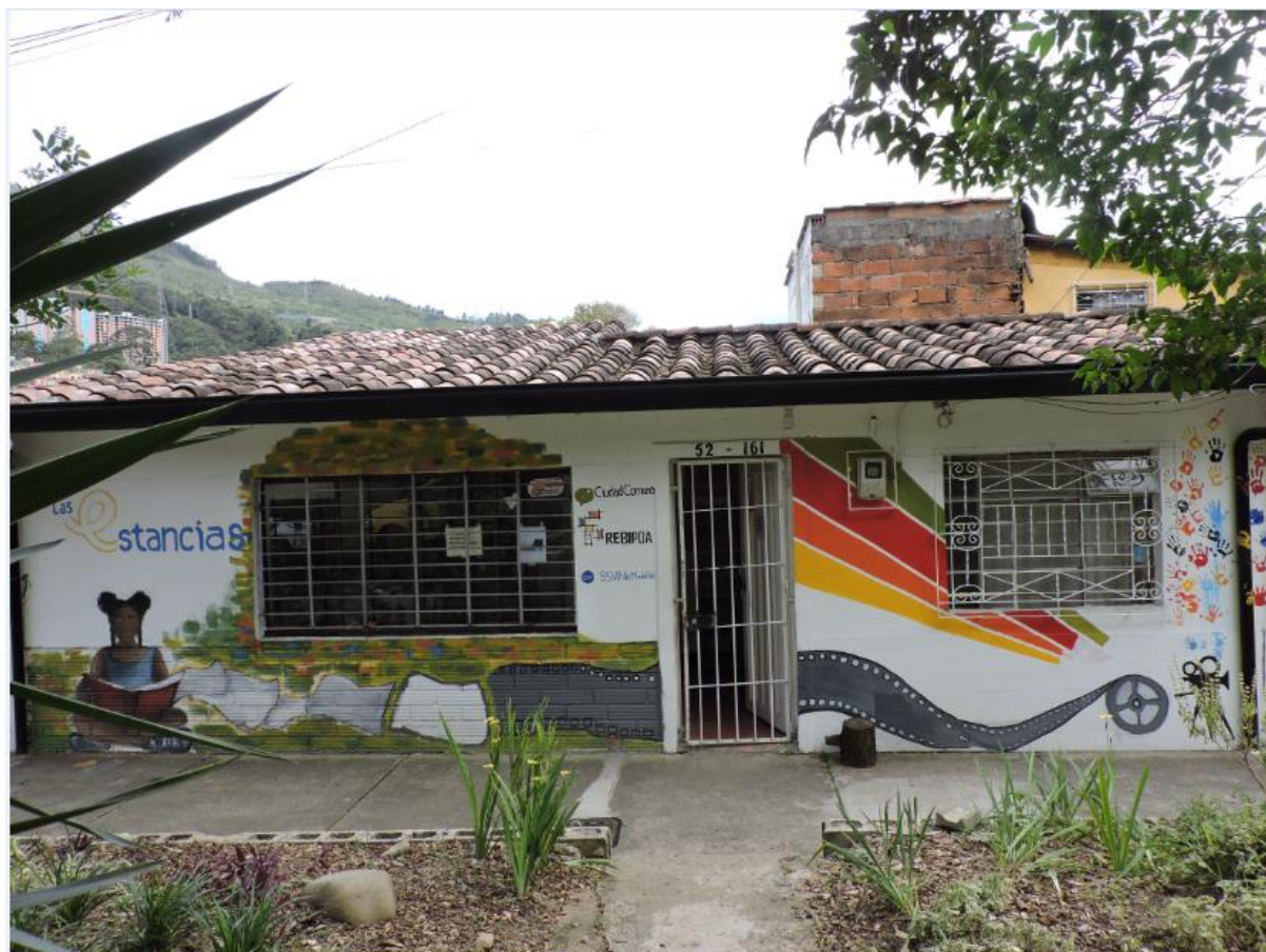
Figura 33 - Fachada do Centro Cultural e Comunitário Las Estancias
