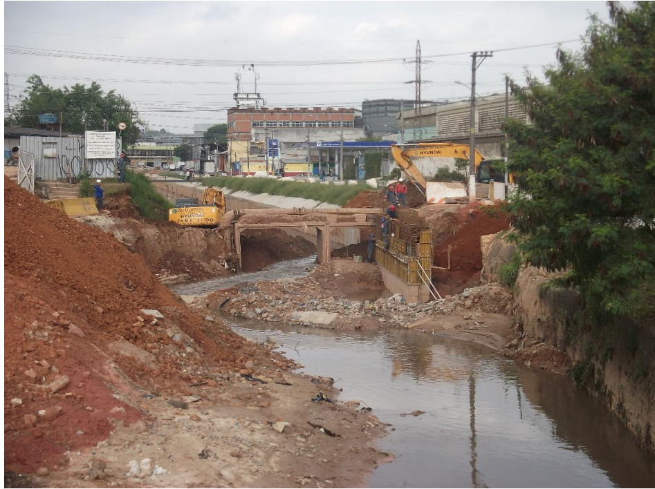
Figura 7: Andamento da obra de construção da ponte no dia 08/10/2013. Fonte: Autoria própria.
