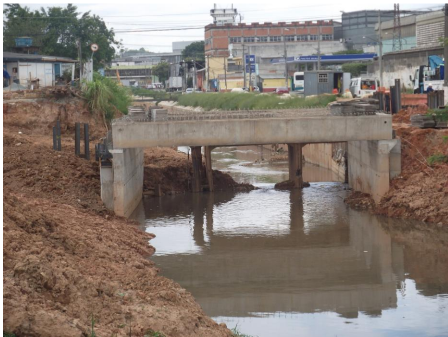
Figura 8: Andamento da obra de construção da ponte no dia 21/05/2014 Fonte: Autoria própria.
