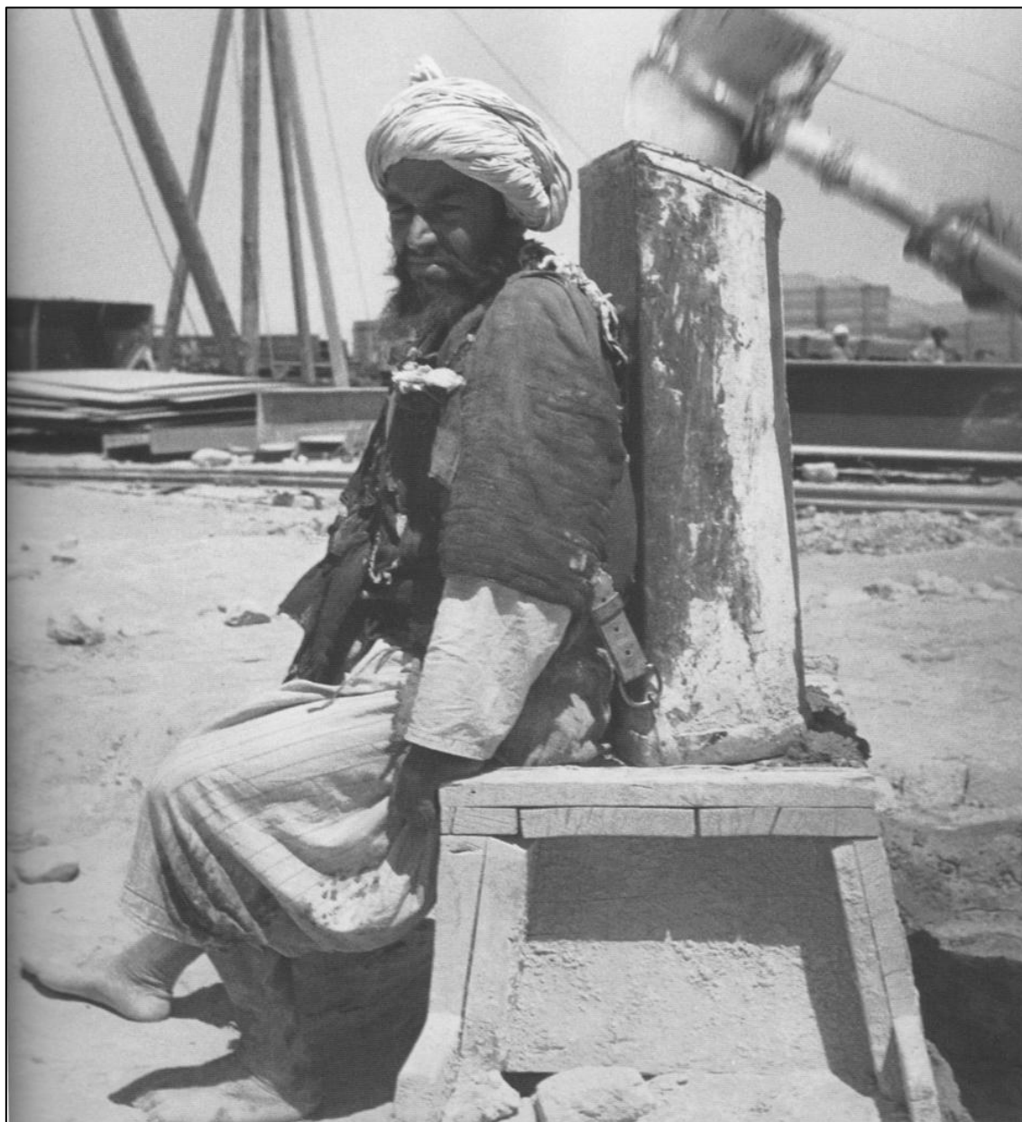
Annemarie Schwarzenbach : Centrale électrique à Poul-i-Khumri/Afghanistan, août 1939, in Bleu immortel , p. 145.
