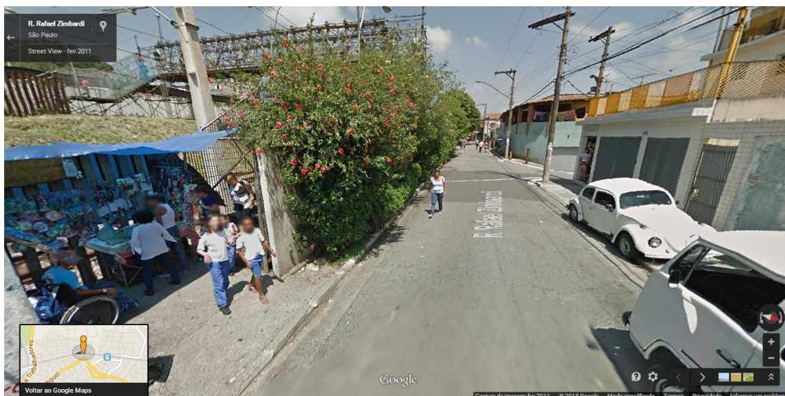
Figura 51. Vista da passarela construída em 2007. Fonte: Google Maps, 2011.
