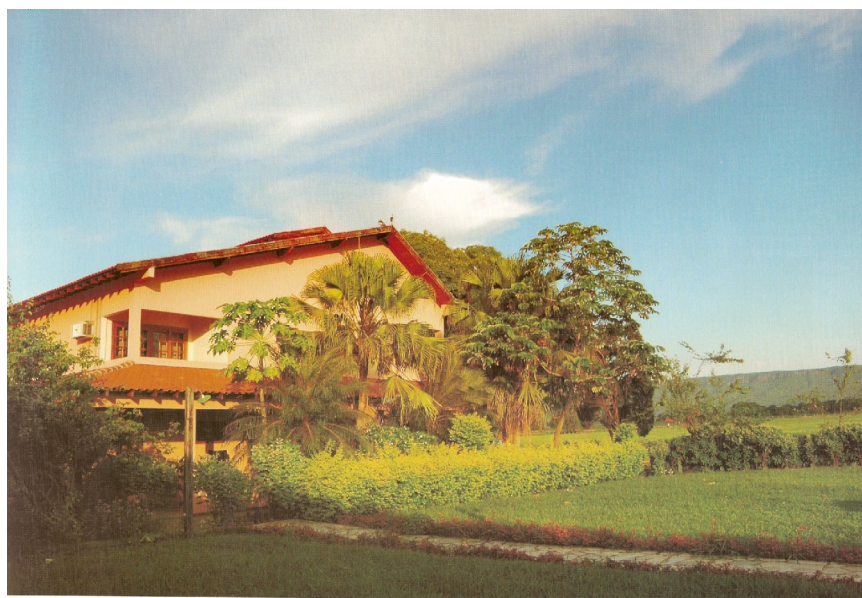
Figura 16 — Sede da Fazenda Santana – Município de Aquidauana – MS
