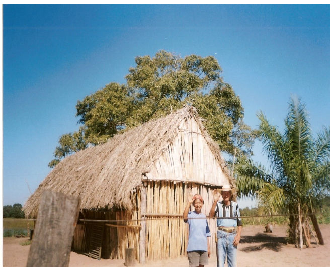
Figura 18 — Casa de pau-a-pique
