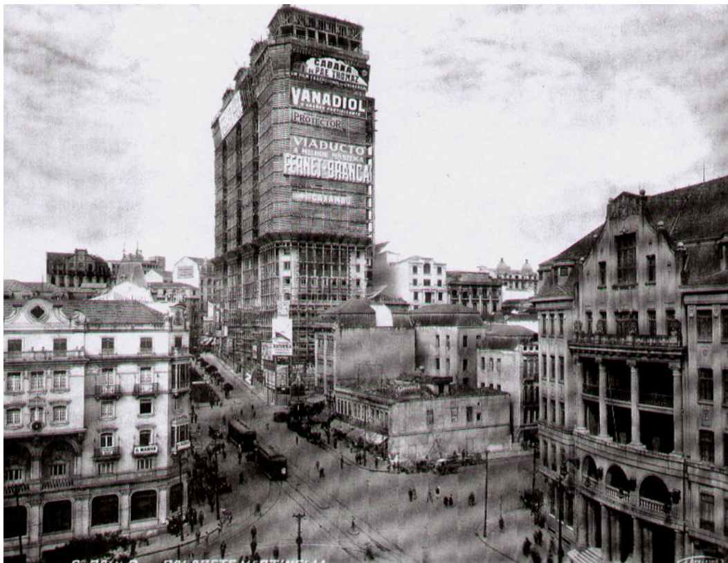
Figura 7: Foto do Edifício Martinelli ainda em construção no ano de 1928. Apresentava anúncios fixados entorno do prédio, na lateral do prédio ficava o anúncio da Água Fernert. Registrada por Theodor Preisng.
