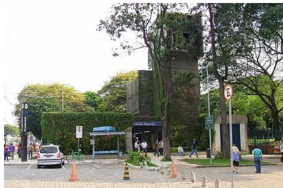
Figura 52 - Entrada da Estação Tiradentes, do metrô. Foto: Dornicke, Wikipedia, 2006
