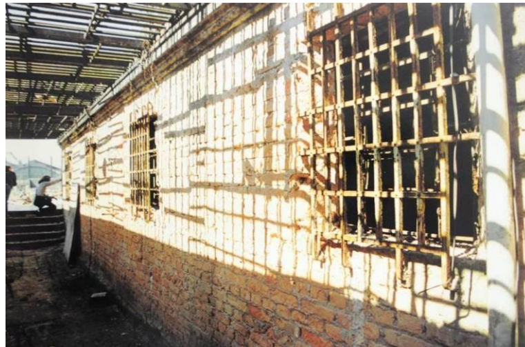
Figura 79 – O corredor durante as reformas, com as celas do fundão já demolidas. Foto: Acervo Arquivo do Estado de São Paulo, circa 2000.
