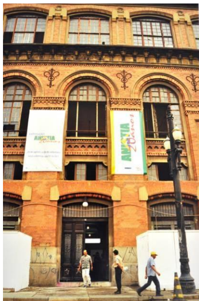
Figura 64 – Fachada frontal do edifício já em reformas, com os cartazes de anúncio da exposição “Anistia 20 anos”. Foto: Arquivo Público do Estado de São Paulo.
