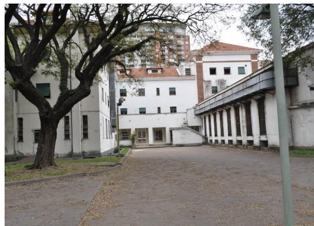
Figura 100 – Parte posterior do edifício. No centro da foto, ao lado direito está a caixa da escada que leva ao porão. Foto: Deborah Neves
