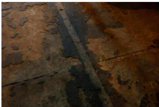
Figura 107 – Indícios no piso que apontam para a existência de divisórias. Foto: Paula Bugni. (Ramona – Revista de Artes Visuales )
