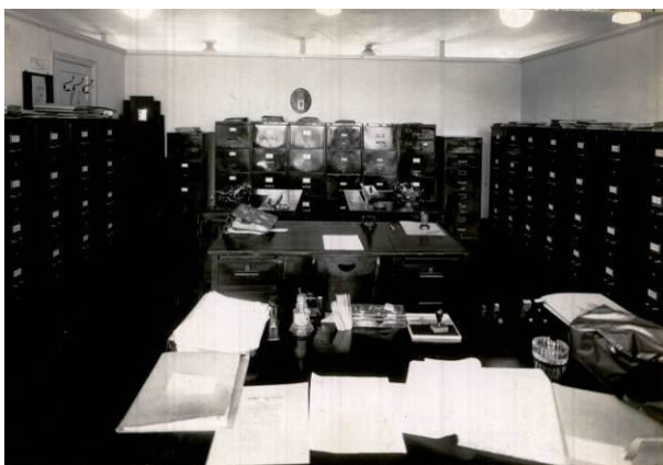
Figura 37 - Sala do Serviço Secreto, localizado no 5º andar. Note-se que havia uma divisória que obstruía a janela. Fonte: Prontuário 126.204-A. Arquivo Público do Estado de São Paulo, 1953.
