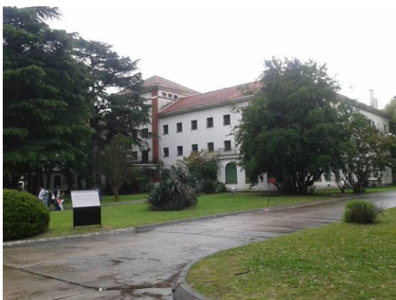
Figura 143 - À esquerda, totem de identificação do Casino de Oficiais. Ao fundo, a fachada principal do edifício. Foto: Deborah Neves (nov.2013)
