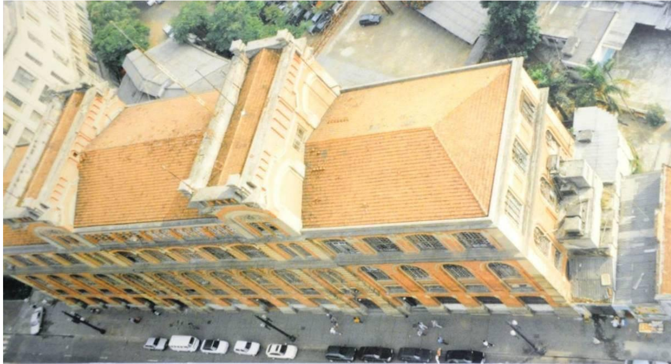
Figura 73 - Imagem aérea do edifício antes da reforma. É possível observar a parte da carceragem externa (fundão), anexada ao lado direito do prédio principal, que durante a reforma foi completamente demolida. Ao lado esquerdo, também no fundo do lote, estava um anexo previsto no projeto original, que também foi demolido durante as reformas. Foto: Acervo Arquivo Público do Estado de São Paulo.
