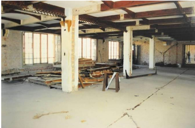
Figura 86 – Segundo andar (bloco lateral), no início das reformas. Fernando Braga, 1999. Acervo Arquivo do Estado de São Paulo.
