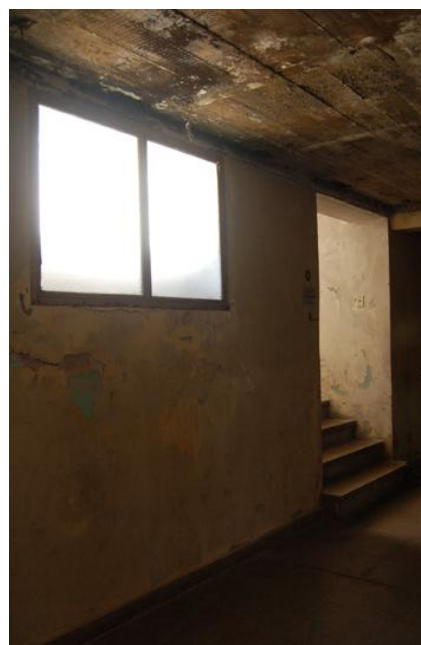
Figura 102 – Parte interna do porão, com janelas na parte alta e acesso à escada, por onde os detidos eram “traslados” para os “vãos da morte”. Foto: Paula Bugni. (Ramona – Revista de Artes Visuales )
