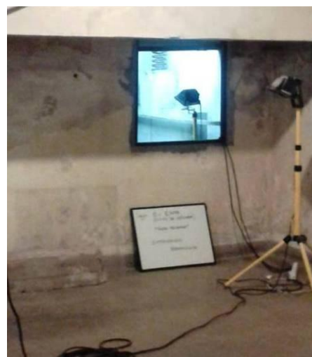
Figura 98 - Recorte na alvenaria que revelou o poço e a mola do elevador. Atualmente passa por prospecção. Foto: Deborah Neves
