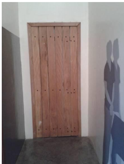
Figura 128 - Porta que levaria às celas do "fundão", demolidas em 1999. Foto: Deborah Neves (dez.2013)
