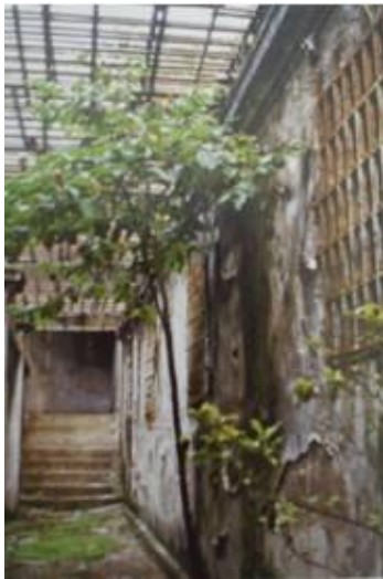
Figura 78 – Corredor de banho de sol, antes do início das reformas. Foto: Memorial da Resistência.
