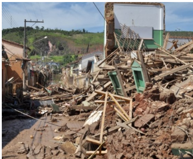
Figura 45 – Prédio escolar destruído em 3 janeiro de 2010.
