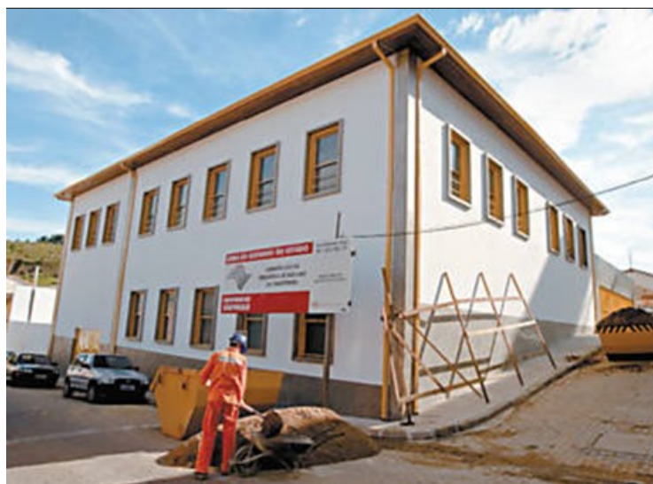
Figura 48 – Sede da nova biblioteca em construção.
