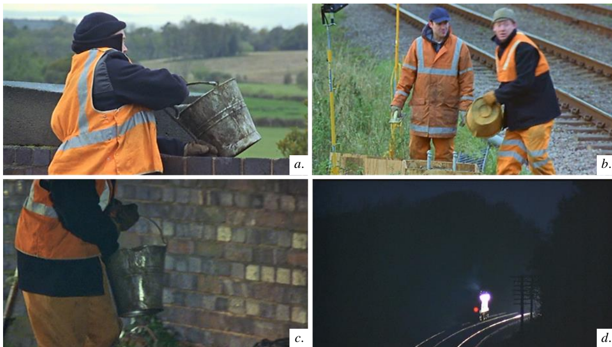
Figura 18 — O acidente de Jim: a. Na pista, Mick passa concreto em um balde para Jim; b. Jim leva o balde para a via férrea abaixo da pista, assumindo uma dupla função: sinaleiro e mão de obra; c. Ao anoitecer, Mick continua passando o balde para Jim; d. Trem silencioso passando na ferrovia
