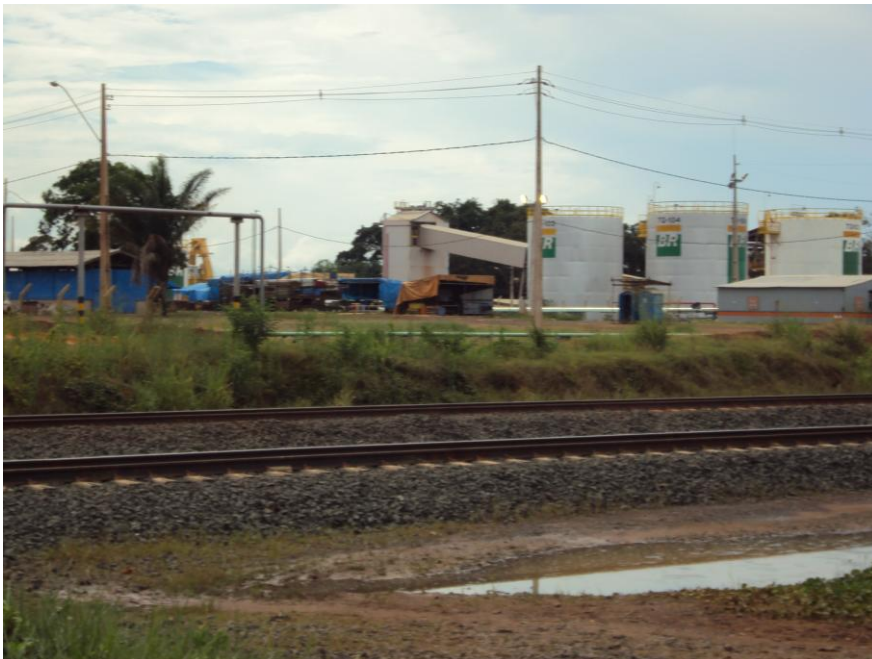
Foto 09: Ferrovia da empresa que transporta bauxita para os navios.
