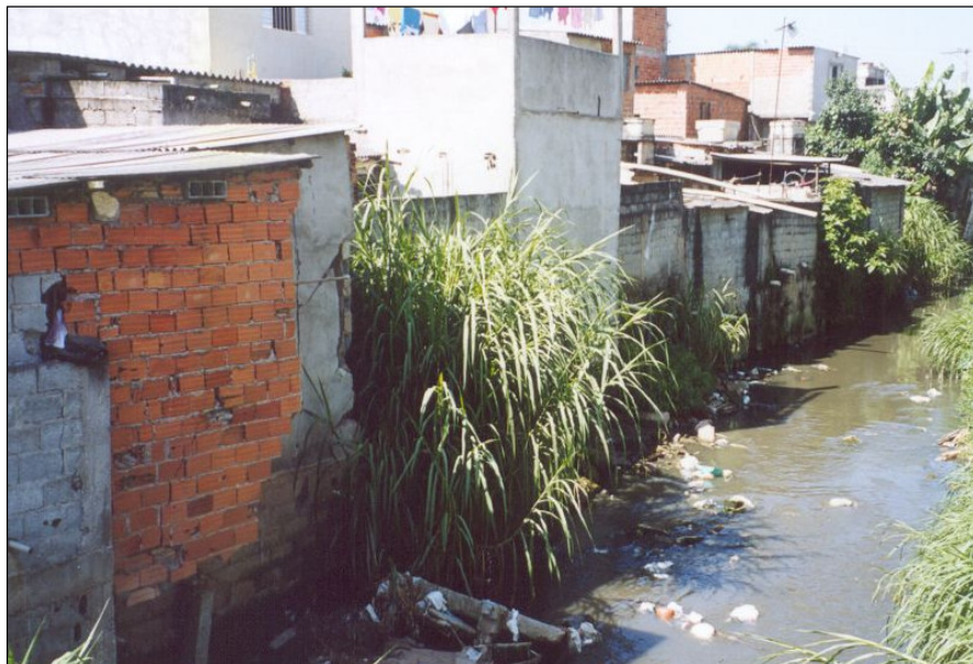
Foto 4. Moradias construídas ao longo do córrego no Jardim Comercial (IPT,2003).
