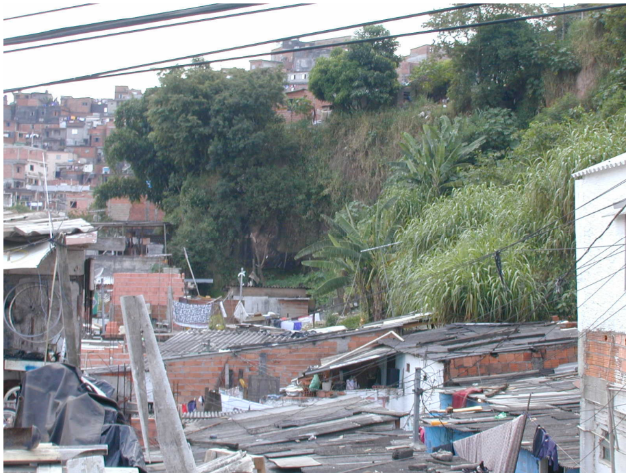
Foto 3. Moradias muito próximas da base do talude e que podem ser atingidas por escorregamento em Cidade Ademar (IPT, 2003).
