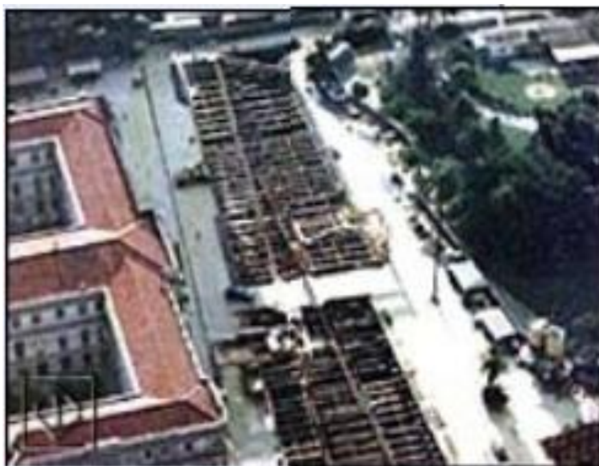
Figura 5: Estação República, início das obras.
