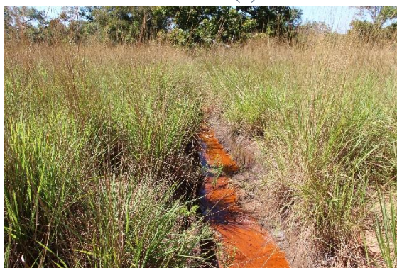
Foto 8 – Melancias: Canal de água assoreado (1)
