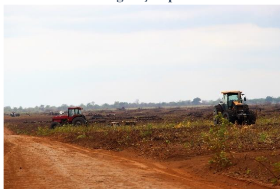
Foto 22 – Fazenda Rocha e Fazenda Baixão Fechado Serra Nova: Amontoamento de restos de vegetação por tratores
