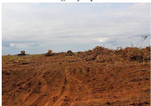
Foto 21 – Fazenda Rocha e Fazenda Baixão Fechado Serra Nova: Amontoamento de restos de vegetação por tratores
