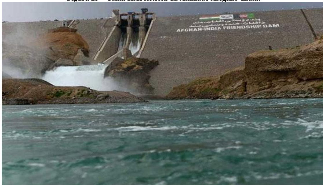
Figura 25 – Usina Hidrelétrica da Amizade Afegano-Índia.
