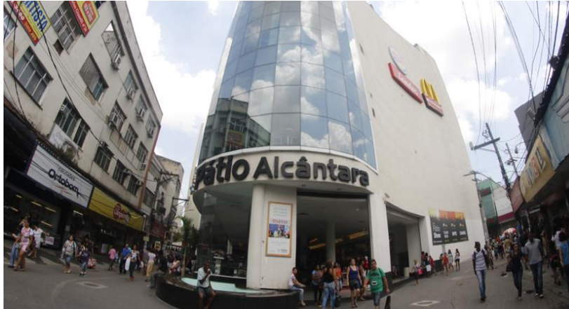
Imagem 35 – Entrada principal do Pátio Alcântara:
