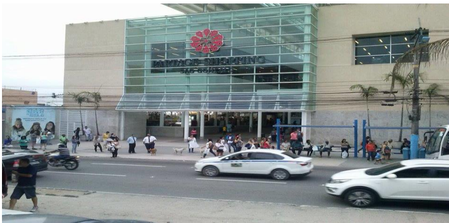
Imagem 12 – Entrada Partage Shopping São Gonçalo:
