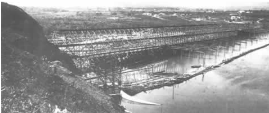
Construção da barragem do Reservatório de Guarapiranga, obra iniciada pela empresa canadense Light and Power ao início do século XX. Fonte: endereço eletrônico http://www.revistaturismo.com.br/passeios/guarapiranga.htm . Última consulta em 01/07/2008, por Giancarlo Livman Frabetti.
