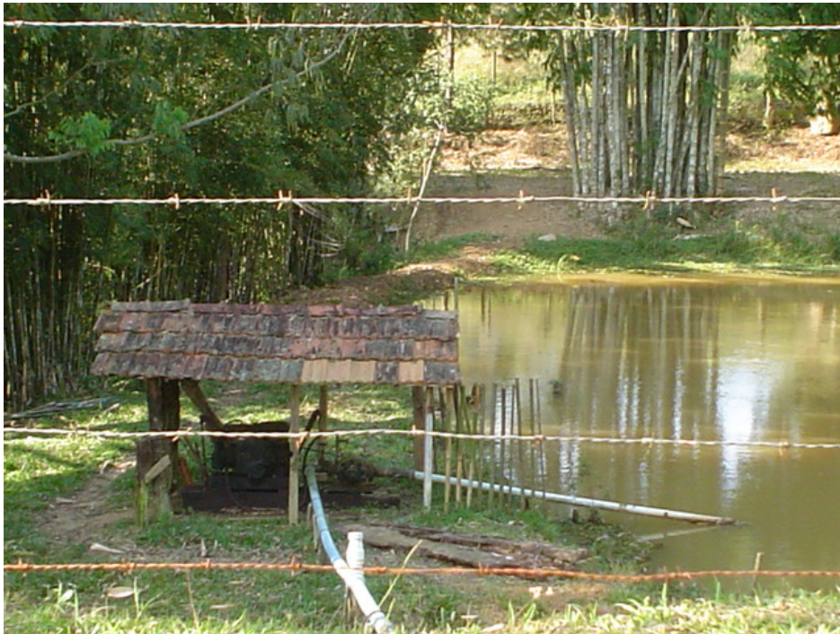
Foto nº 65: represamento construído para irrigação da lavoura
