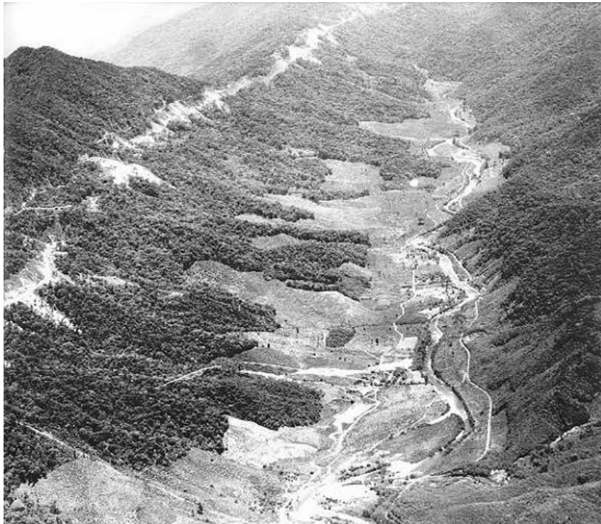
Vista aérea da Serra do Mar (à esquerda) e vale do Rio Cubatão (margeado pela pequena Estrada de Ferro Pilões, à direita), no início da construção da ferrovia Mayrink-Santos (cerca de 1930), notando-se a destruição da floresta pelos construtores Foto: acervos da Fundação do Patrimônio Histórico da Energia em São Paulo/SP e de Marcello Talamo (Santos/SP), publicada no site http://www.pell.portland.or.us/~efbrazil/efs_mayrinksantos.html .
