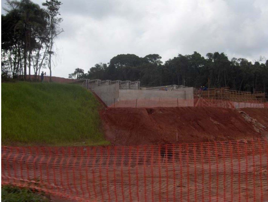
Foto nº 100: trecho das obras do Rodoanel
