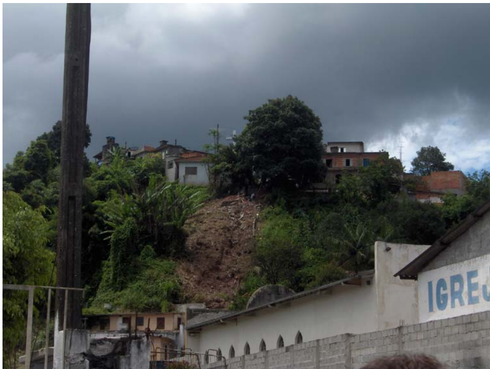
Esta fotografia, tirada no centro de Parelheiros, em torno do qual ergue-se uma faixa de habitações precariamente estabelecidas (tanto no que se refere à forma de apropriação da terra, quanto no que se refere às condições de salubridade nessas casas), releva, ao alto de uma encosta extremamente íngreme e sem qualquer cobertura vegetal, construções nas quais vivem famílias de trabalhadores proletarizados, em sua maioria desempregados ou subempregados. Fonte: trabalho de campo, janeiro de 2008. Autoria de Giancarlo Livman Frabetti.
