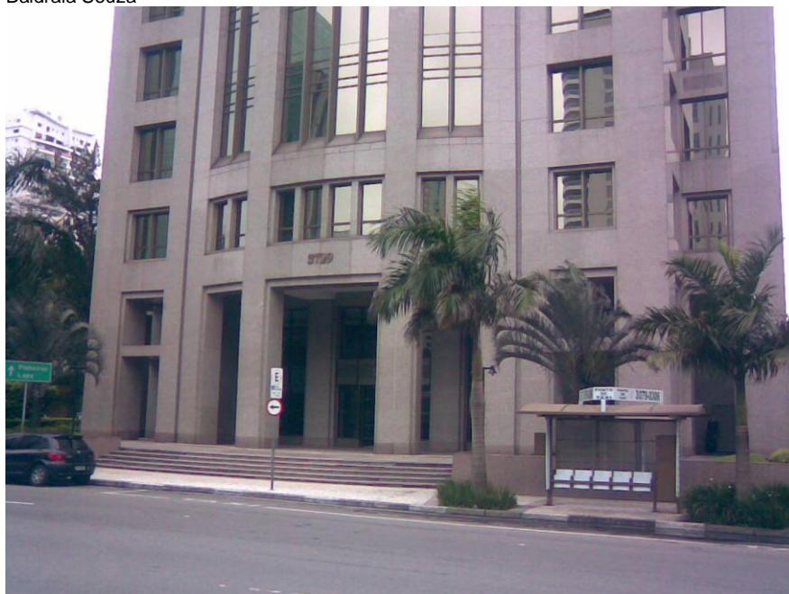
FOTO 16 – Agência Banco do Brasil Estilo Juscelino Kubitschek, vista de frente a partir da Avenida Brigadeiro Faria Lima, 3729. O prédio não possui identificação externa. Além da agência do Banco do Brasil Estilo, sedia também a única Agência Banco do Brasil Private de São Paulo, além dos Bancos JP Morgan e UBS Pactual – Dezembro de 2006. Foto: André dos Santos Baldraia Souza
