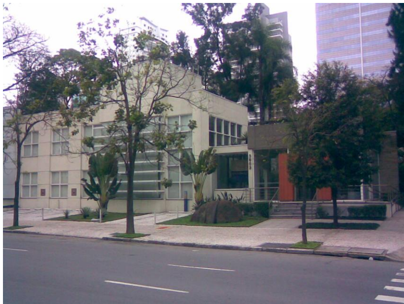
FOTO 17 – Agência Itaú Personalité , vista de frente a partir da Brigadeiro Faria Lima Dezembro de 2006. Foto: André dos Santos Baldraia Souza
