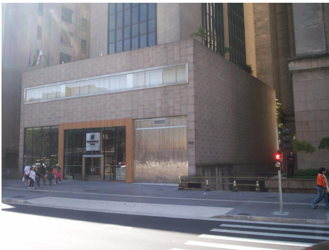
FOTO 7 – Agência Banco do Brasil Estilo Paulista, vista de frente a partir da Avenida Paulista – Dezembro de 2006. Foto: André dos Santos Baldraia Souza
