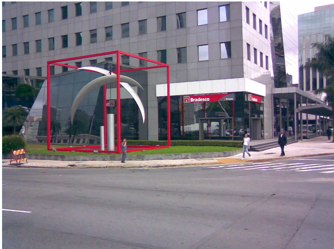
FOTO 14 – Agência Bradesco Prime , vista de frente a partir da Avenida Brigadeiro Faria Lima – Dezembro de 2006. Foto: André dos Santos Baldraia Souza
