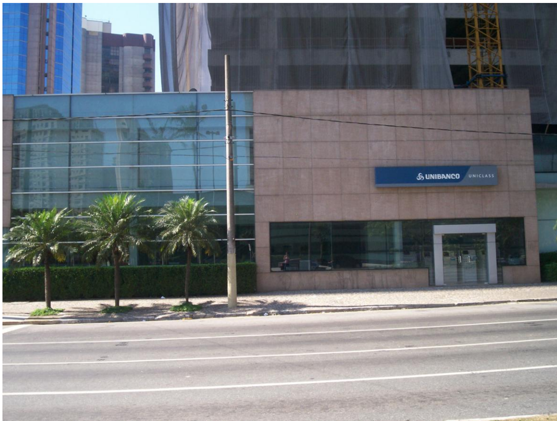
FOTO 11 – Agência Unibanco Uniclass , vista de frente a partir da Avenida Brigadeiro Faria Lima – Dezembro de 2006. Foto: André dos Santos Baldraia Souza
