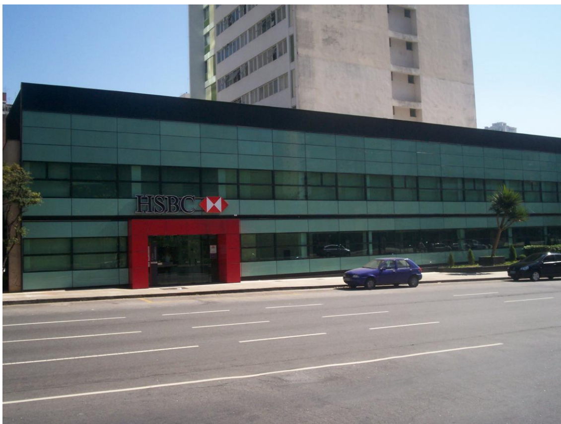
FOTO 12 – Agência HSBS Premier , vista de frente a partir da Avenida Brigadeiro Faria Lima – Dezembro de 2006. Foto: André dos Santos Baldraia Souza
