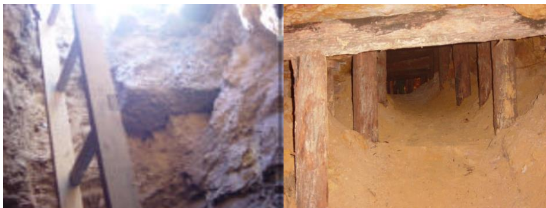
Figura 12- Escoramento e aterro realizado na galeria abaixo da residência no bairro Maria Céu em Criciúma
