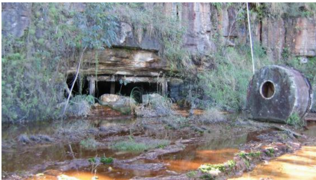
Figura 33 - Boca de mina abandonada - SC
