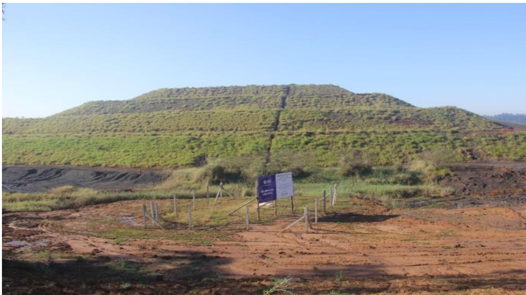
Figura 23 - Depósito de rejeitos recoberto por material argiloso e vegetação
