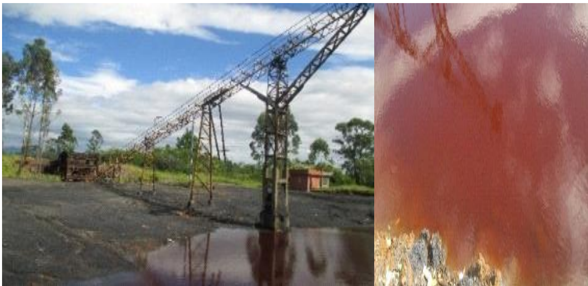
Figura 26 - Depósito de carvão abandonado - lagoas ácidas- Treviso – SC
