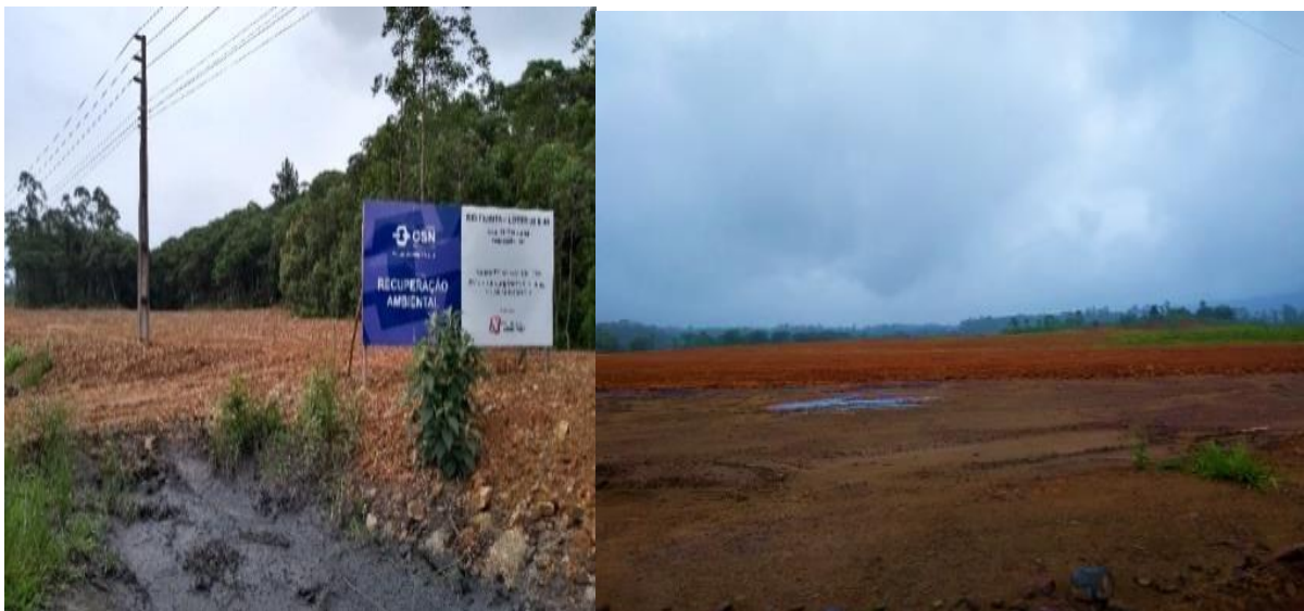
Figura 18 - Preparo do solo na área para o plantio
