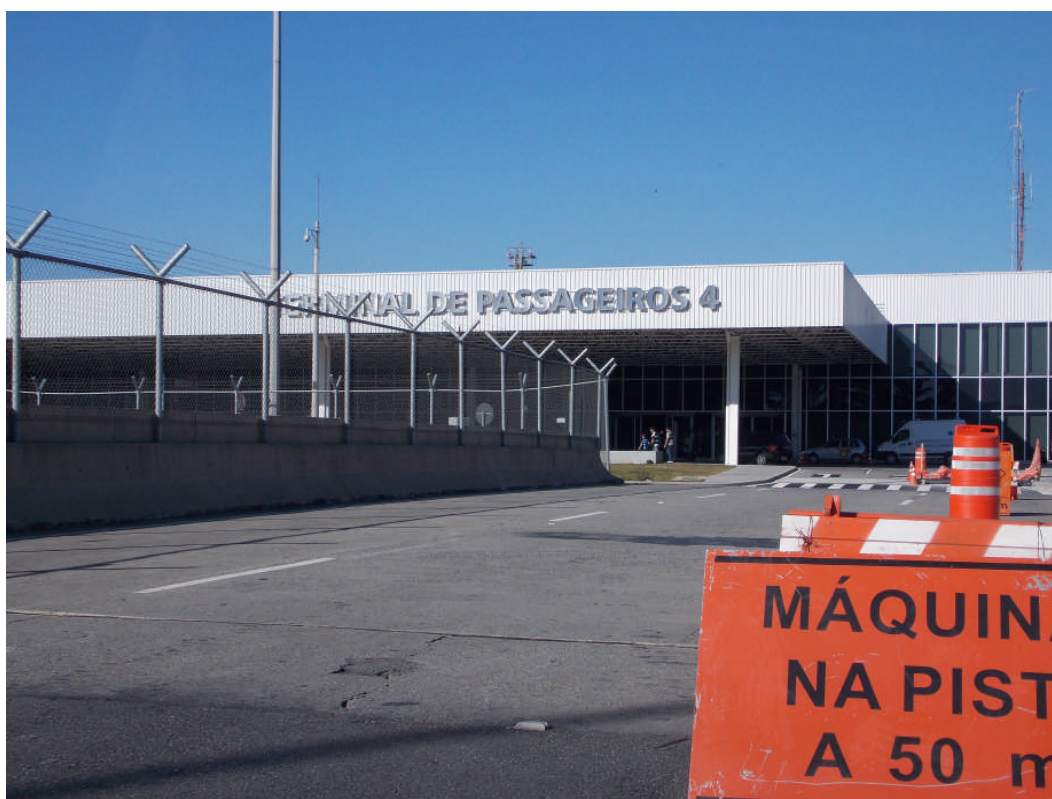
Foto 13: Terminal 4 do Aeroporto – Guarulhos (SP) Fonte: Foto do autor / julho de 2012.
