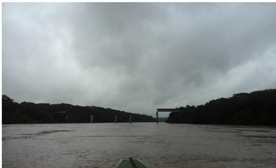
Figura 49: Ponte inacabada sobre o Rio Sono.
