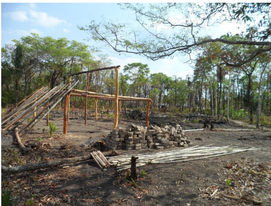
Figura 31: Casa em construção na aldeia Zekâ Fonte: Arquivo pessoal da pesquisadora, setembro de 2016.
