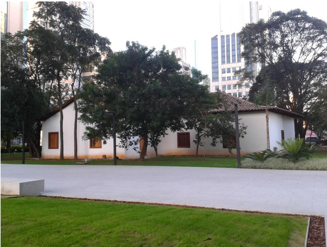
Foto 2.2. Sede do Sítio Itaim reconstruída, 2013. Foto da autora.
