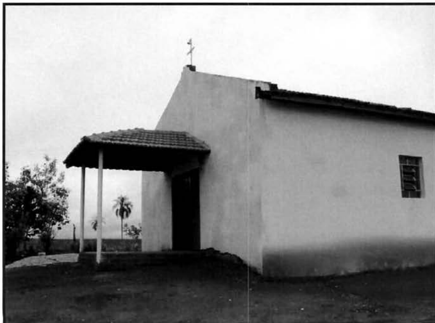
126. Igreja do bairro rural Cafezal Velho.
