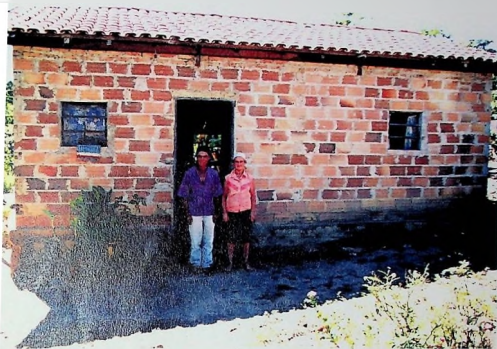
foto 1: Casa feita em alvenaria e sem reboco, o tipo mais comum na área
