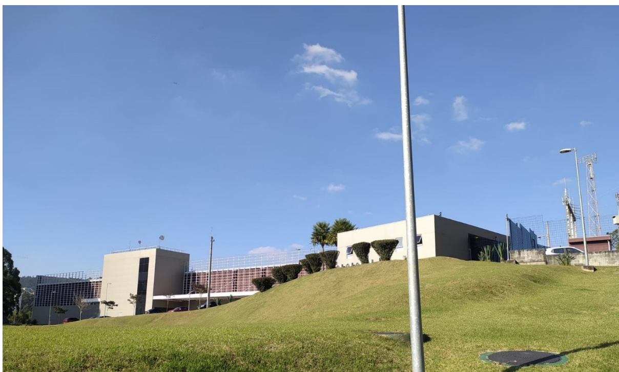
Figura 2. Datacenter da B3 (2022)
