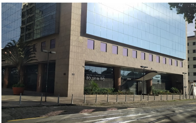
Figura 1. Edifício que pertenceu à Bolsa do Rio abrigando centro de convenções (2022)
