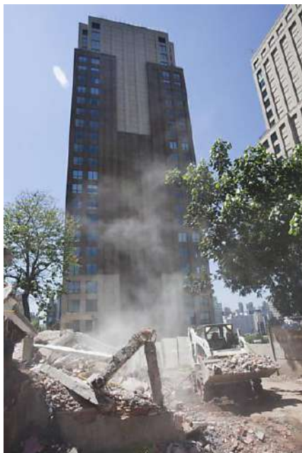
Figuras 24 e 25 - Residências demolidas nas proximidades da rua Armando Petrella.
