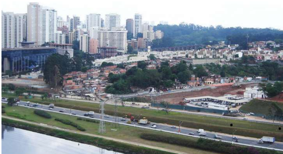
Figuras 13 e 14 - Antes e depois da demolição dos barracos da região do morrão. [D'ANDREA, 2008].
