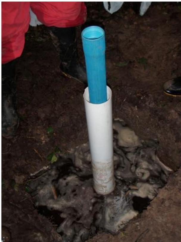
Figura 16: Piezômetro instalado, ainda posicionado dentro do tubo-guia.
