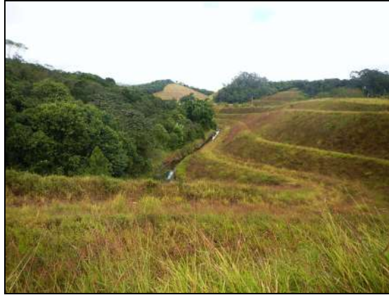
Figura 36 – Visão dos dispositivos de drenagem 5
