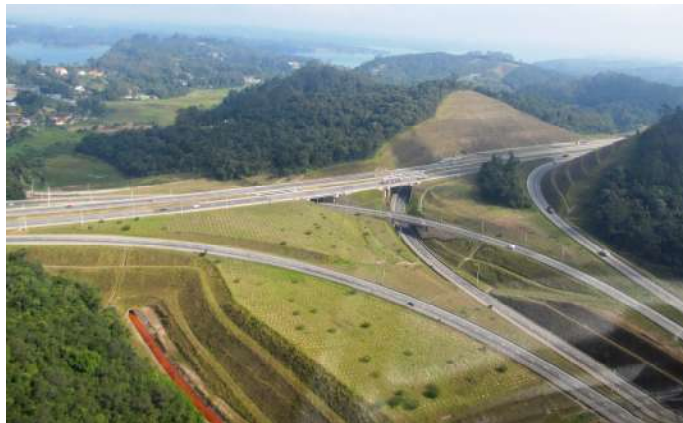
Figura 37 – Visão dos dispositivos de drenagem 6
