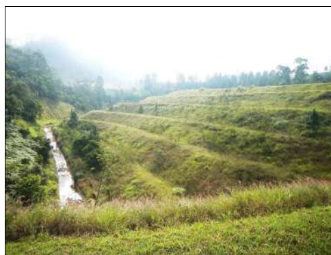
Figura 35. Visão dispositivos de drenagem 4. Canaleta de drenagem direcionando os fluxos provenientes dos anfiteatros côncavos amplos, com pátio de veículos ao fundo e aterro com materiais excedentes da obra, ao lado.
