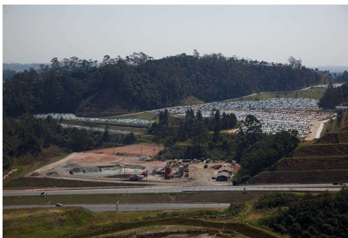
FIGURA 27 - Perspectiva aérea oblíqua 3 do canteiro de obra principal do Rodoanel.
