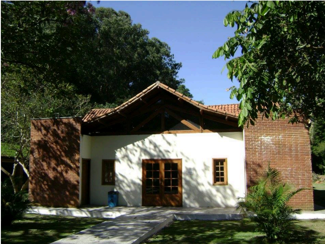
Imagem 07 – Capela Ecumênica Casa do Caminho, nas dependências da APMBB (Fonte: Acervo / Autorização)
