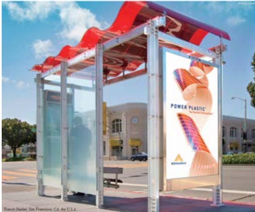
Figura 3 – Ponto de ônibus com iluminação noturna abastecida por energia solar gerada na cobertura de painéis de OPV (Konarka ® ).
