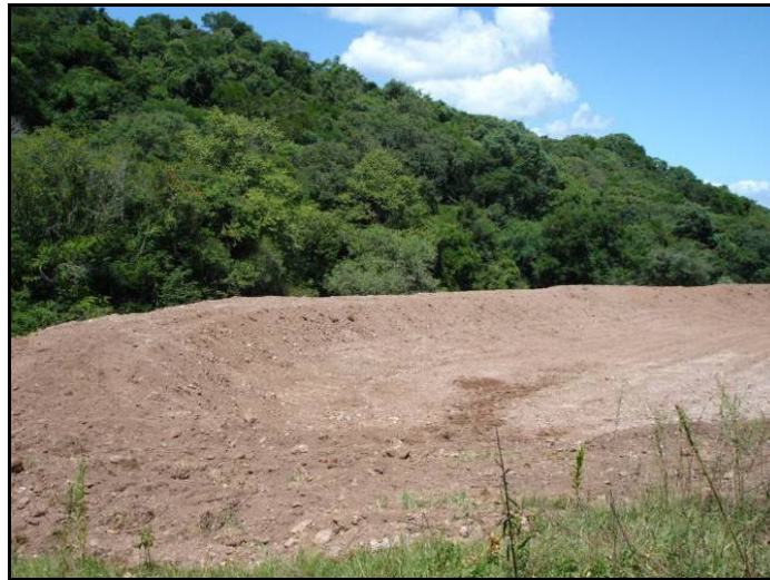
Foto 4 - Construção de pequenos aterros que servem como reservatório de água para os animais. Foto: Juliana R. Santi.
