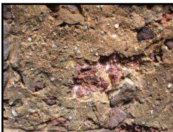
Fig. 36. Detalhe da parede em uma das estruturas encontradas no Sítio do Físico, no Parque Estadual do Bacanga, com a argamassa formada a partir da junção entre argila, pedra e concha queima. Foto: Arkley Bandeira, 2006.
