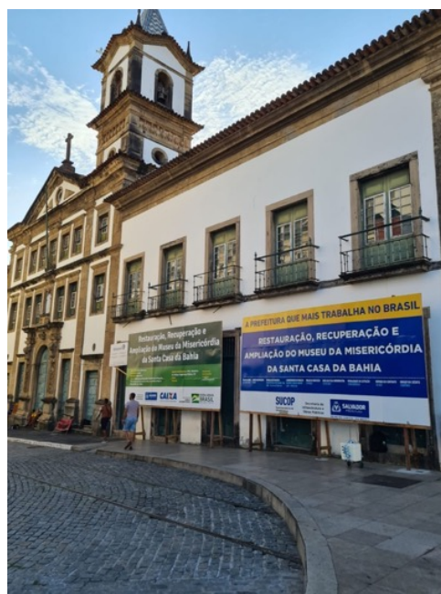
Figura 27 - Fachada em reforma do Museu da Misericórdia, localizado no Centro Histórico de Salvador
