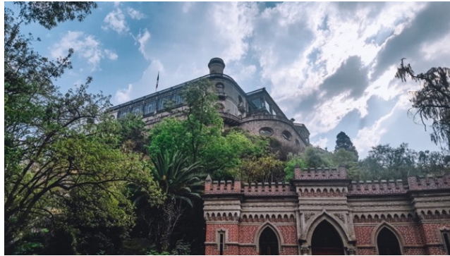
Figura 25 - Fachada do Castelo de Chapultepec, na Cidade do México, México
